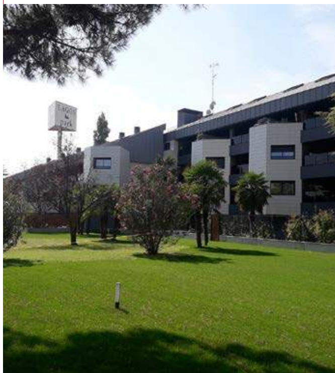
Viviendas Lago Park (Madrid) Sistema instalado: Q-ton Bomba de calor con CO 2
