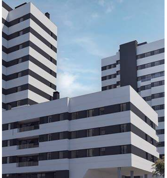
Viviendas AEDAS HOMES (Cornellá de Llobregat, Barcelona) Sistema Instalado: Q-ton Bomba de calor con CO 2
