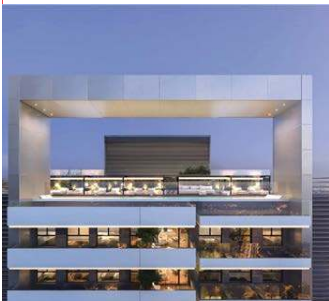
Torre Madrid Skyline (Madrid) Sistema Instalado: Q-ton Bomba de calor con CO 2
