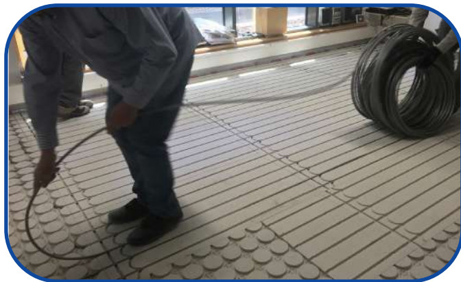
5.- Colocación tubo de los distintos circuitos.
