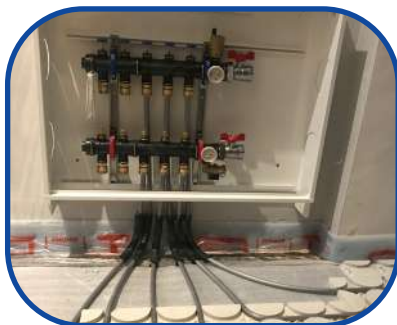
5.- Colocación tubo de los distintos circuitos.
