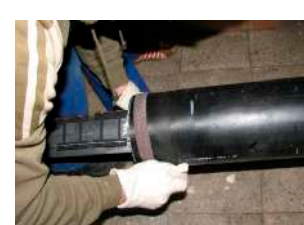
4. Limpiar y lijar el área donde va a ir la camisa.
